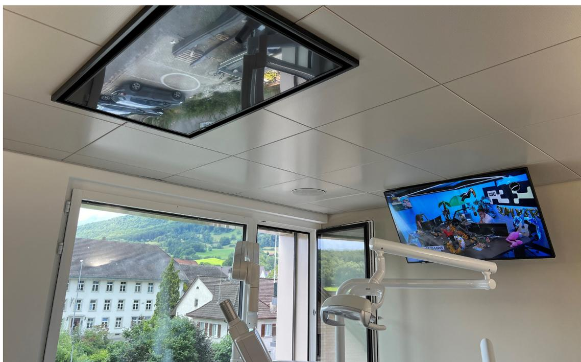
Die Displays wurden dazu auf Signalerkennung konfiguriert. Das HDMI-Feature CEC (Consumer Electronics Control) wurde hingegen deaktiviert, damit sich die Displays auch unabhängig von Apple TV bedienen lassen.
